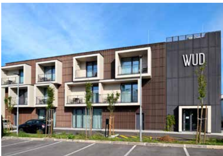
Hotel WUD - Slovenia Architect: SoNo Arhitekti, Obrat
