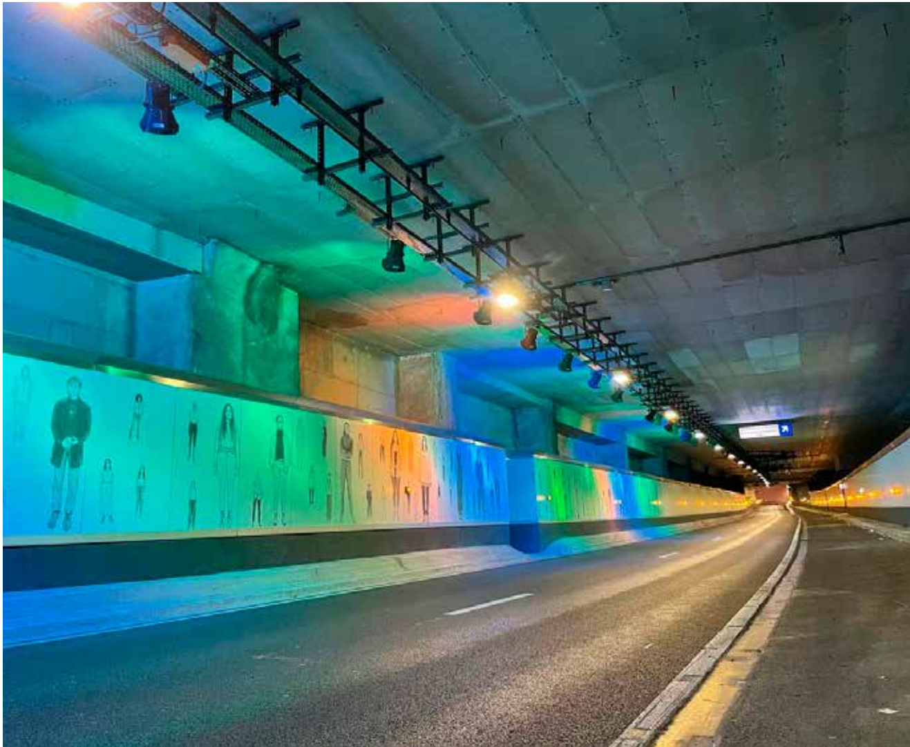
Anny Cordie Tunnel - Bruxelles
