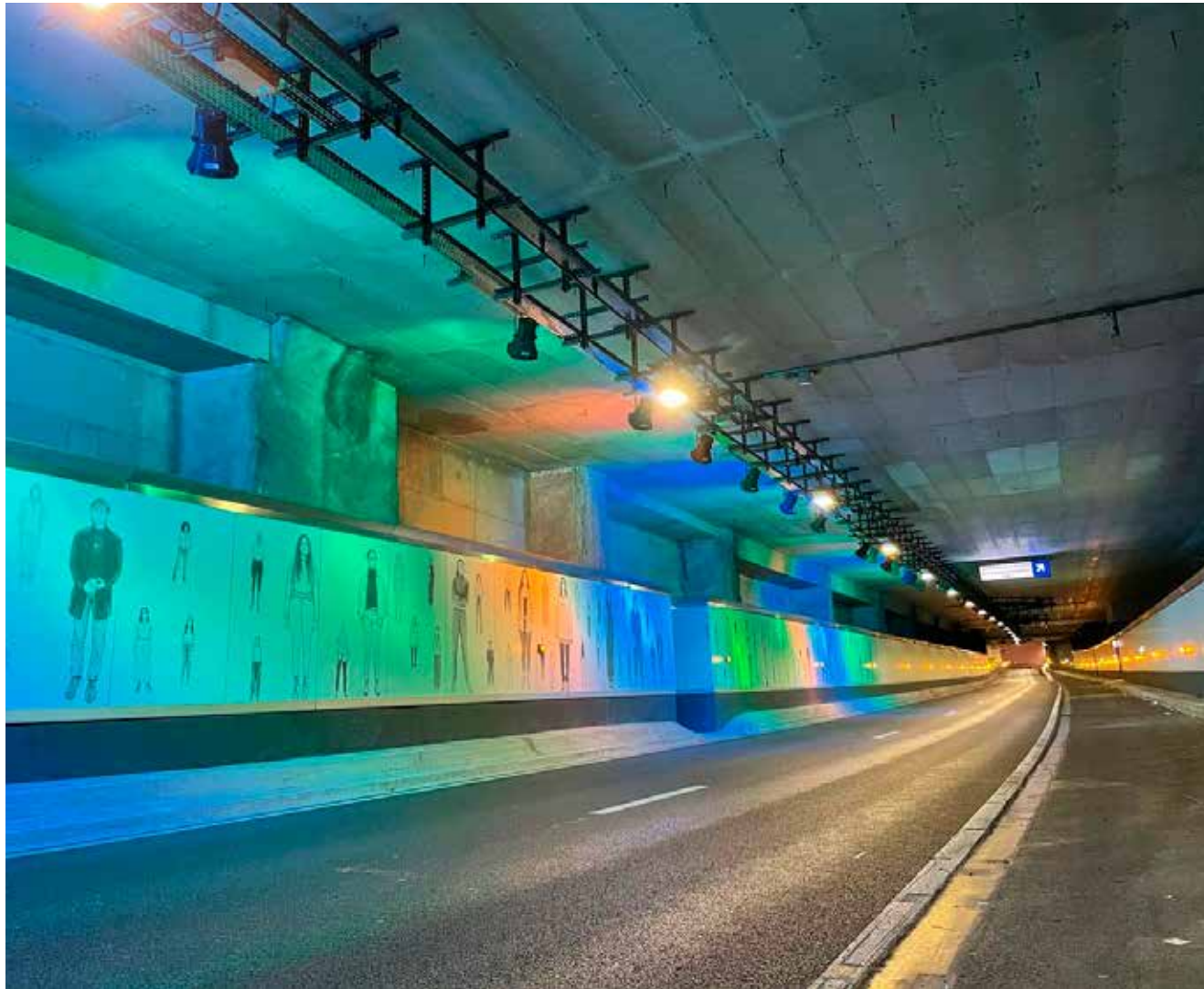
Anny Cordie Tunnel - Bruxelles
